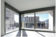
Acristalamiento con doble vidrio acústico con cámara de aire tipo "Climalit"
